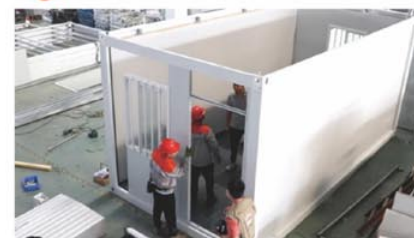
7 Instalar puertas y ventanas
