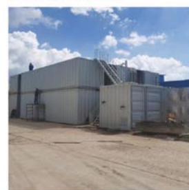
Contenedor de Filtración de Aguas Residuales
