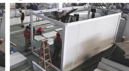
6 Instalar los paneles de pared
