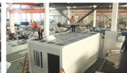
8 Instalar las placas del techo y las correas del techo
