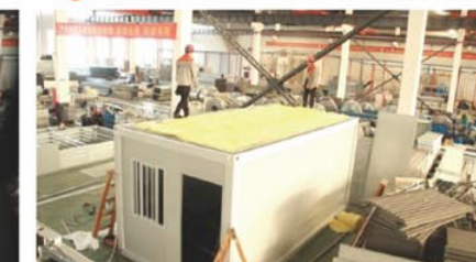
9 Colocar la capa de aislamiento sobre las correas del techo
