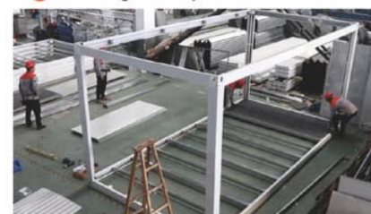
4 Colocar los paneles del suelo sobre las correas del suelo
