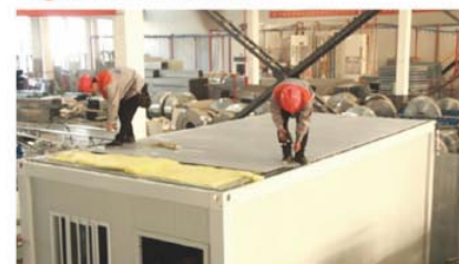
10 Instalar las placas del techo y aplicar sellador en los tornillos
